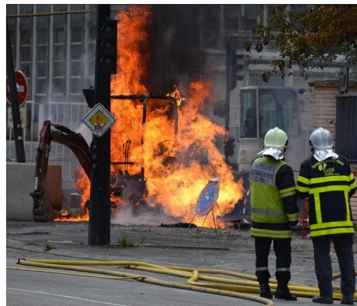
Absence de marquage du branchement
